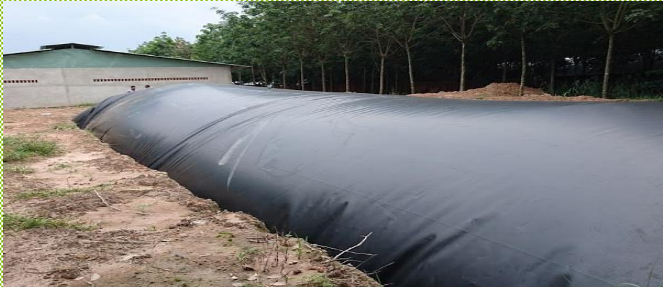
Hầm phủ bạt HDPE
